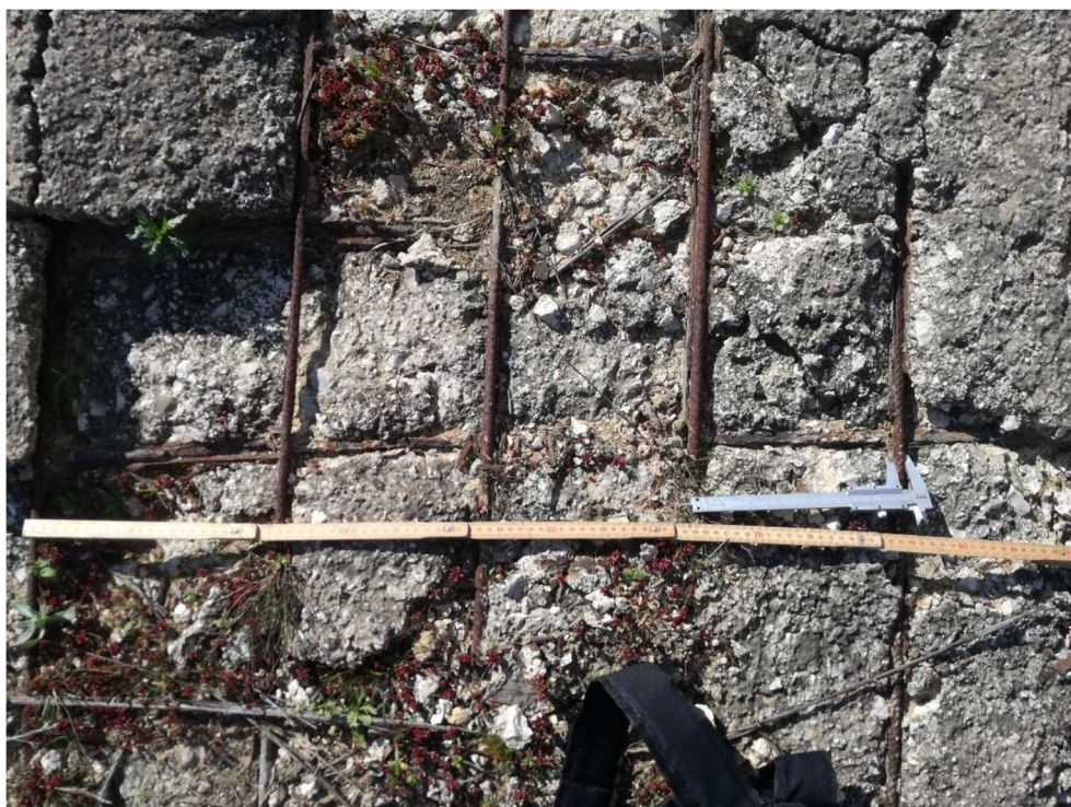
Figura 4.8: Canale di restituzione – Particolare armature ossidate
