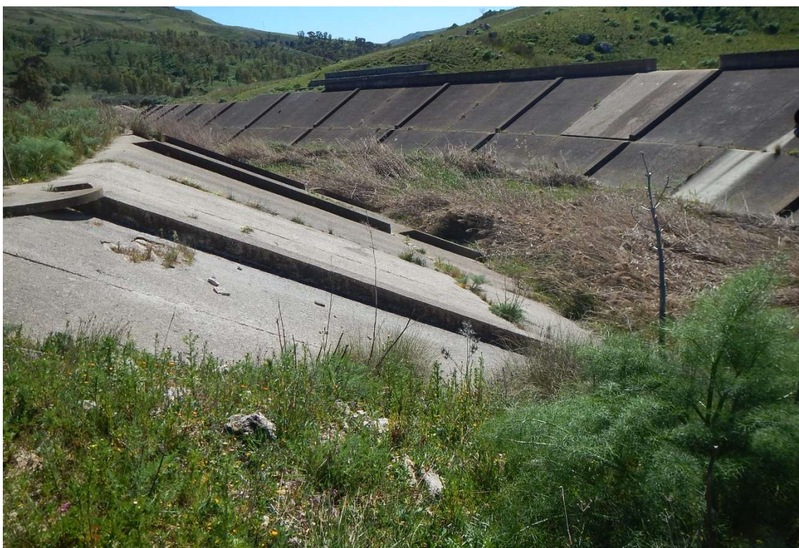
Figura 3.3: Canale di restituzione in alveo
